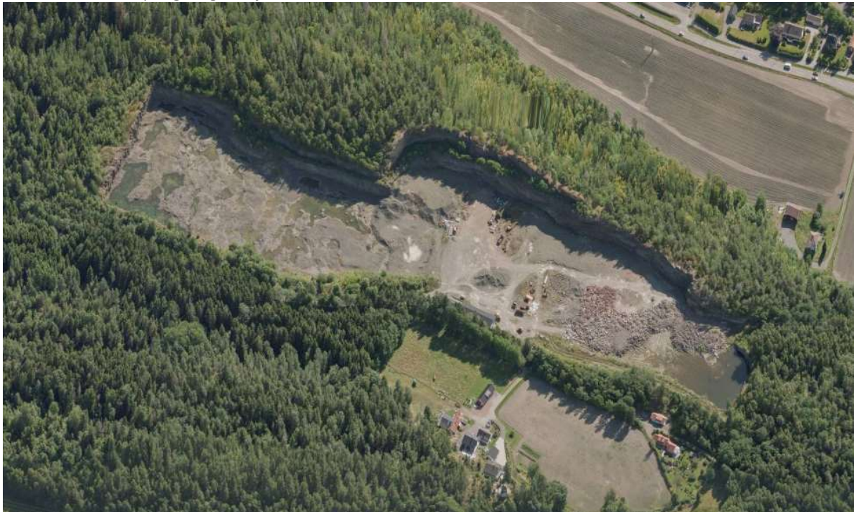
Figur 2: Utsnitt av flyfoto over området. Pukkverksområdet kommer tydelig frem i landskapet, og er omringet av skog og landbruksarealer. Noe skog er ryddet i nordvestlig del av området. Hentet fra Færder kommunes kartløsning.
