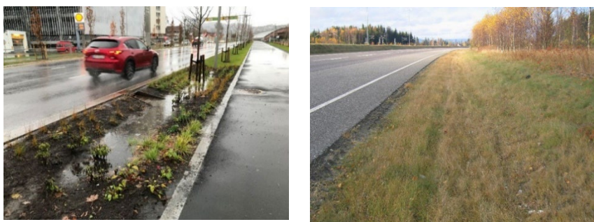
Figur 6-7 Eksempel på nedsenket grøntrabatt (filtergrøft) i bygate med avrenning fra kjørebane gjennom kantstein til filtersonen (venstre). Gaten har ingen sluk/sandfang i kjørebanen (foto: Kirstine Laukli, SVV). Til høyre filtergrøft langs motorvei (foto: COWI AS).
