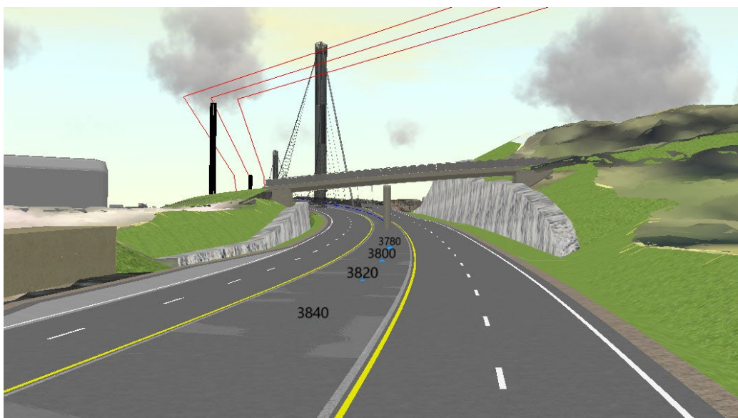
Figur 4-14 Tiltakene sett motsatt vei. G/s-brua i front foran høybrua i horisonten, og med skjæring gjennom Høienkoll. Teknisk bygg til venstre.
