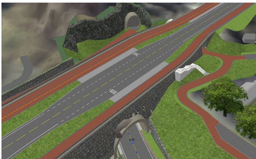
Figur 4-4: Tunnelportal i front, og rømningstunnel bak Kirkeveien. Snarvei i form av trapper ses til høyre.
