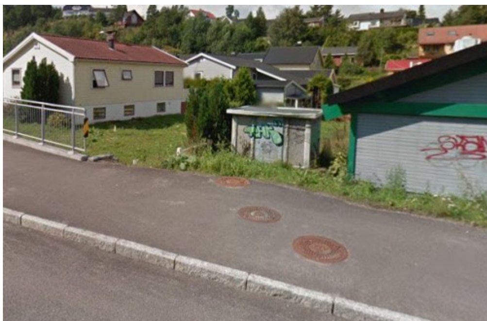
Figur 9-8 Typisk utseende og plassering av eksisterende nettstasjon (FV 428 Munkerekkeveien)
