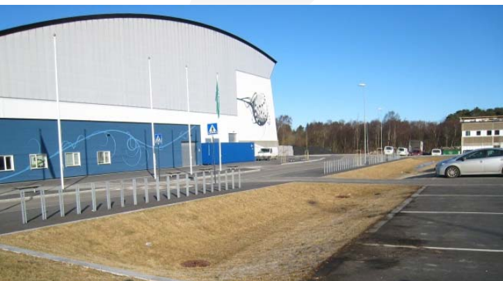
Nedsenket infiltrasjonssone for overvann fra P-plass ved Randaberg Arena (foto: Randaberg kommune)
