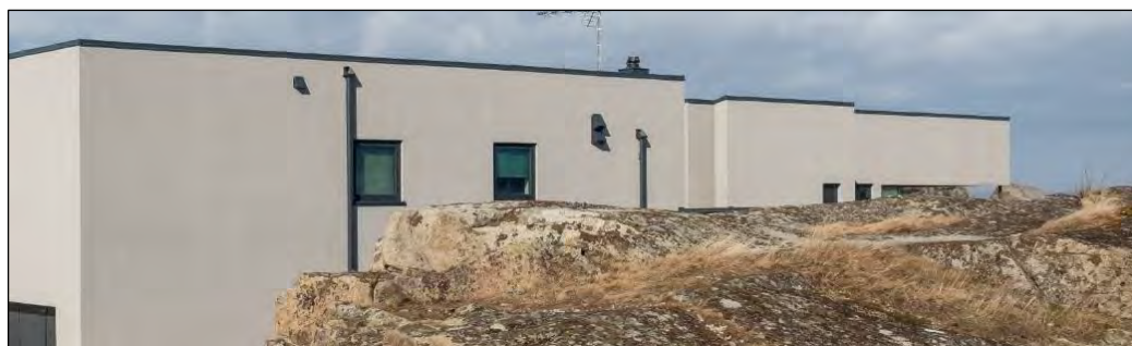
Figur 49: Fasaden for bygg 1 (FTU1) sett fra øst bak fjellkollen, slik den fremstår i dag.
