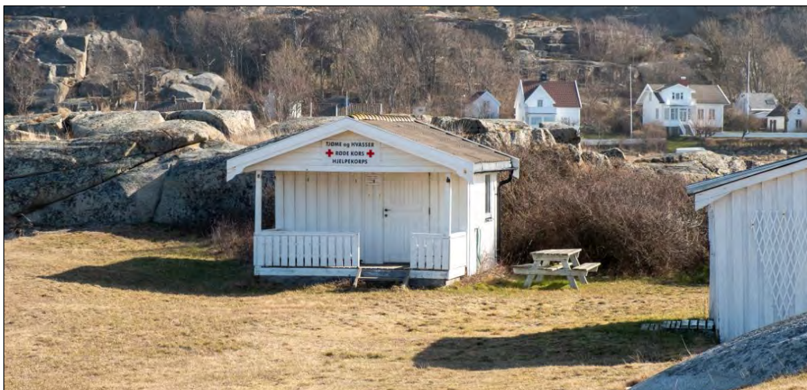
Figur 22: Røde kors bygget ved stranda, og ligger på eiendommen 244/1 som eies av Færder kommune.
