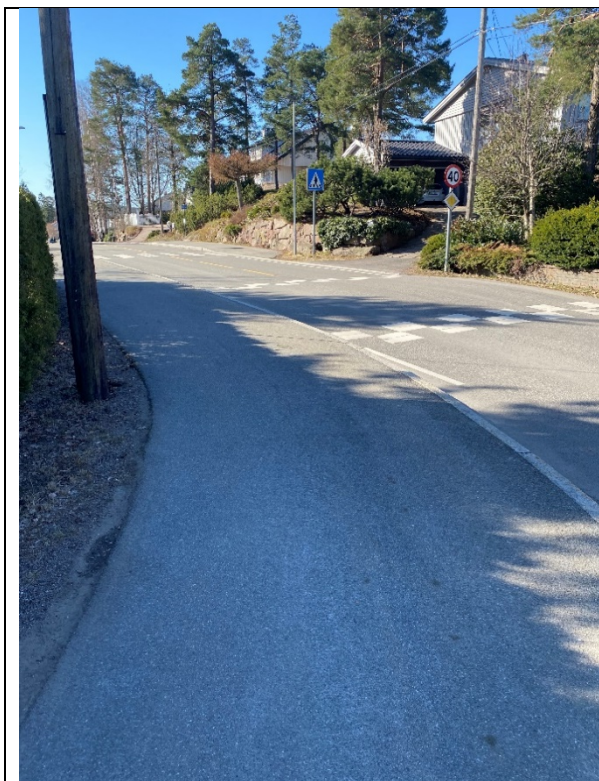
Bilde 7: Amundrødveien 33 og 35 i retning sør, fjell i dagen
