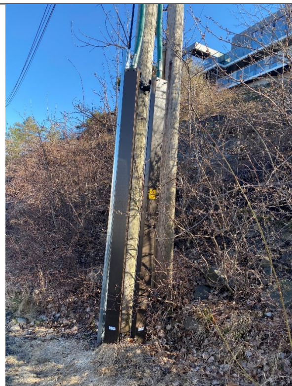
Bilde 3: Fra Furusetveien retning mot øst, fjell i dagen
