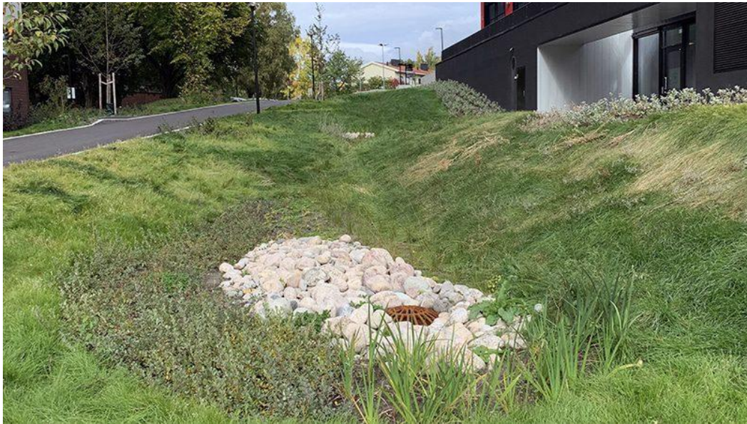
Figur 14 – Illustrasjon av nedsenkning/ tørrdam (Norsk Vann)
