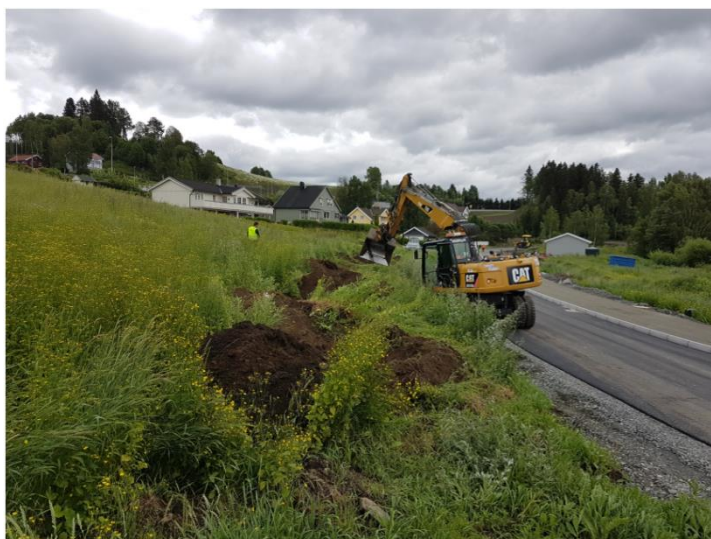
Figur 3: Bilder. Venstre - graving av prøvehull for etablering av overflateinfiltrasjon, høyre - sjakting av prøvehull
