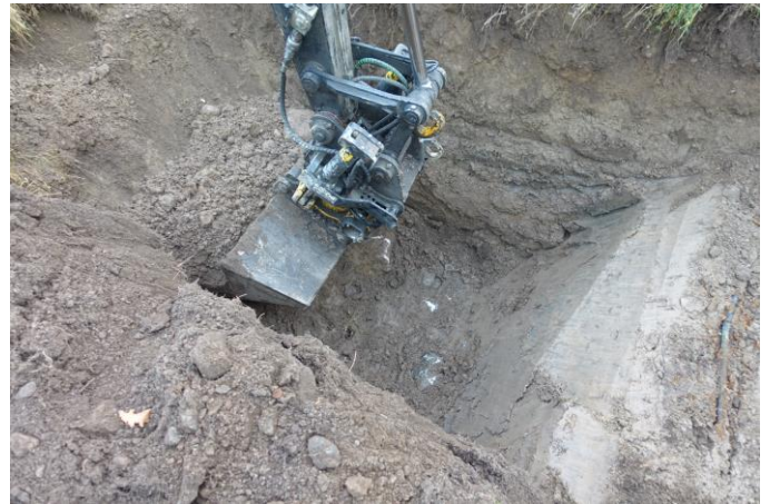
Bilde 8+9. GH4. Plassering og masser. Steinig morene i bunnen, antatt nært til fjell.
