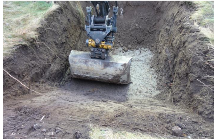
Bilde 6+7. GH2, plassering og bunn GH2. Stoppet i tørrskorpeleire pga punkt inne i byggegrop Hus A.
