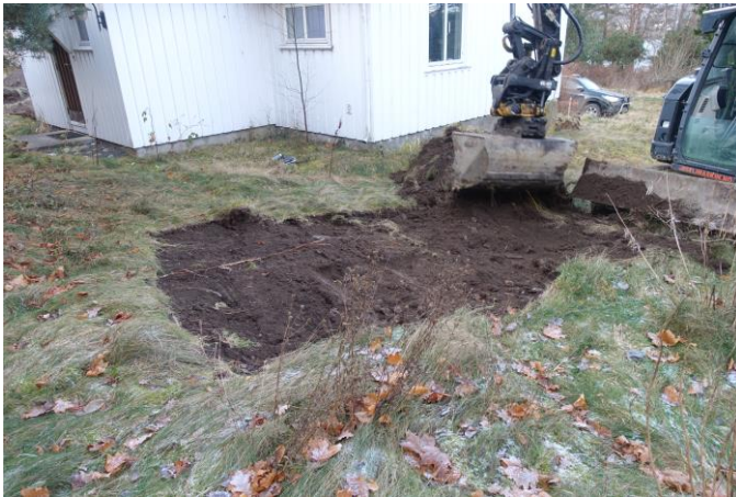
Bilde 8+9. GH4. Plassering og masser. Steinig morene i bunnen, antatt nært til fjell.
