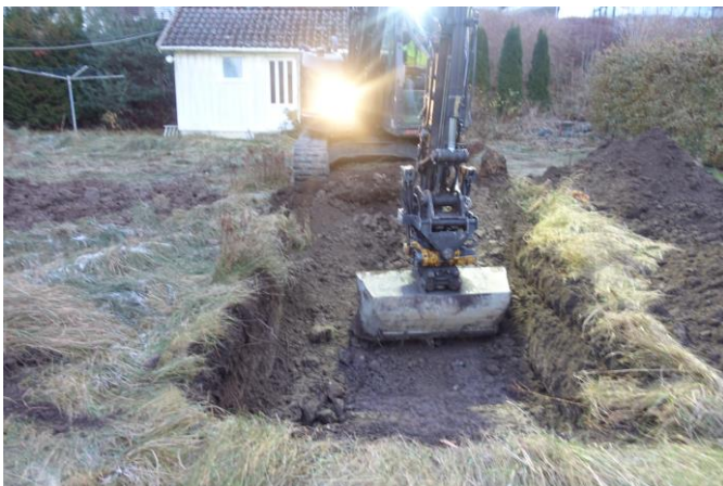
Bilde 6+7. GH2, plassering og bunn GH2. Stoppet i tørrskorpeleire pga punkt inne i byggegrop Hus A.
