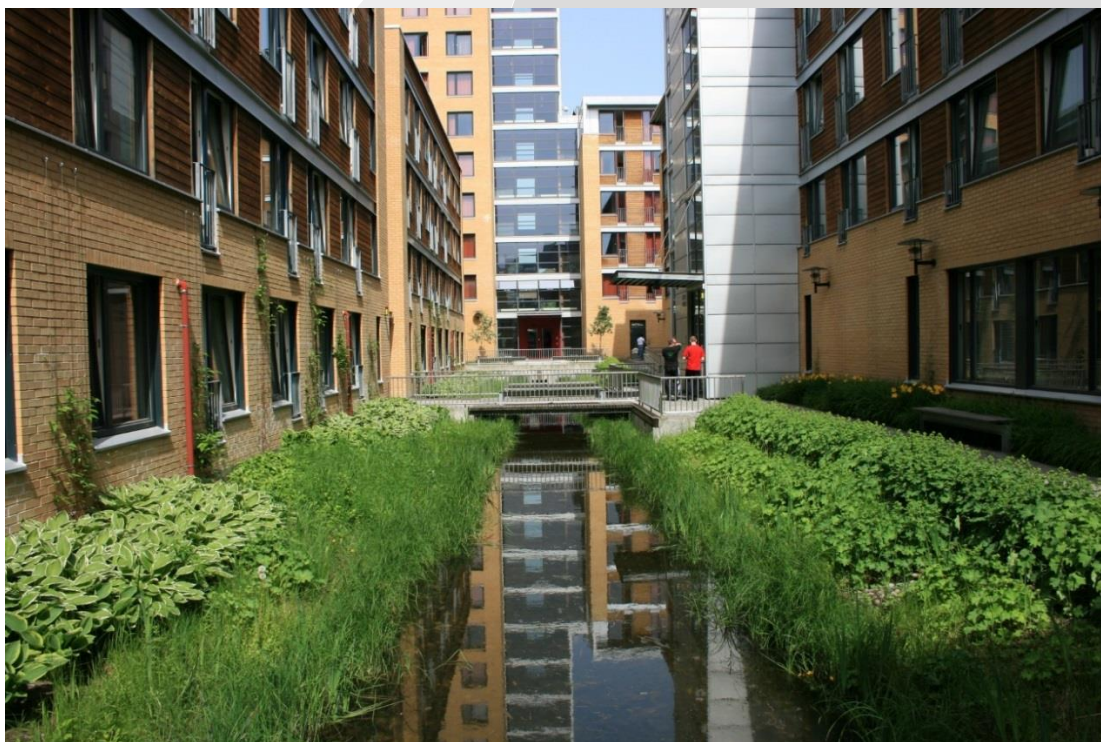
Åpen fordrøyningsdam for overvann i tett bebyggelse (foto:Rainer Stange/Dronninga landskap)
