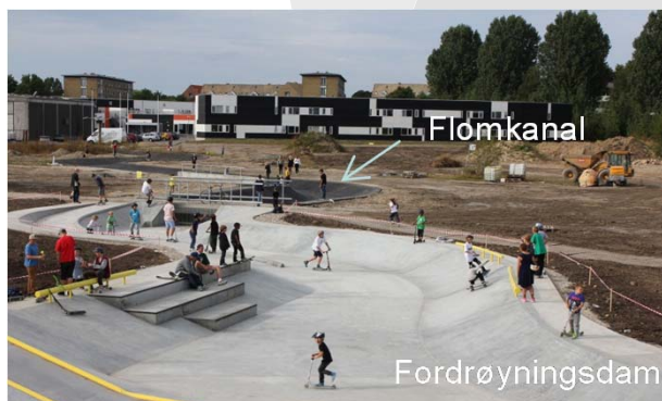
Åpent fordrøyningsbasseng i terreng-forsenkning tilrettelagt for flerbruk (sportsaktiviteter) (høyre) (Washington DC, foto: COWI).
