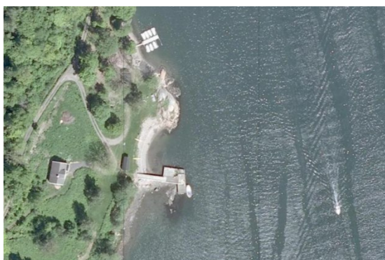
Figur4 Flyfoto som viser eksisterende anlegg i bruk.
