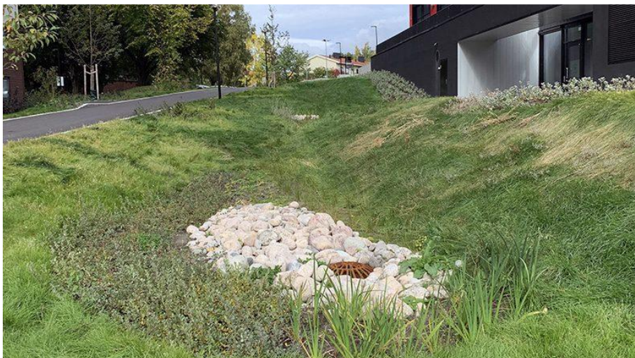
Illustrasjon for hvordan en Tørrdammer/vadi kan bygges
