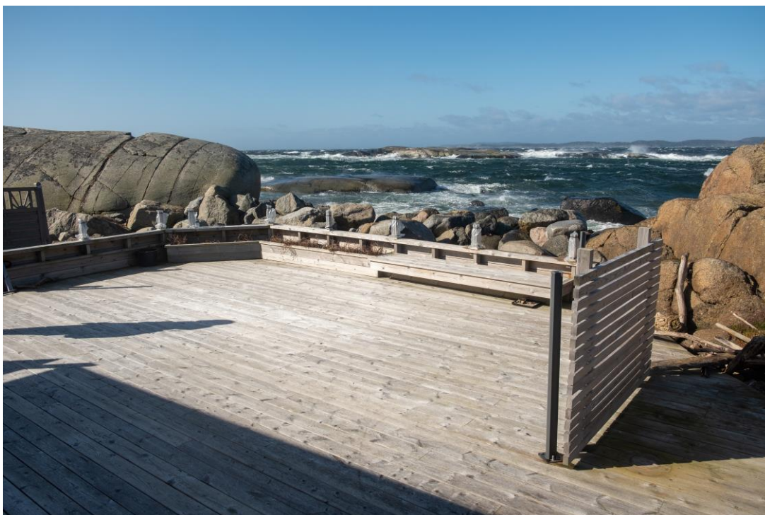
Figur 19 Steinblokker lagt ut i åpningen mellom svabergene.
