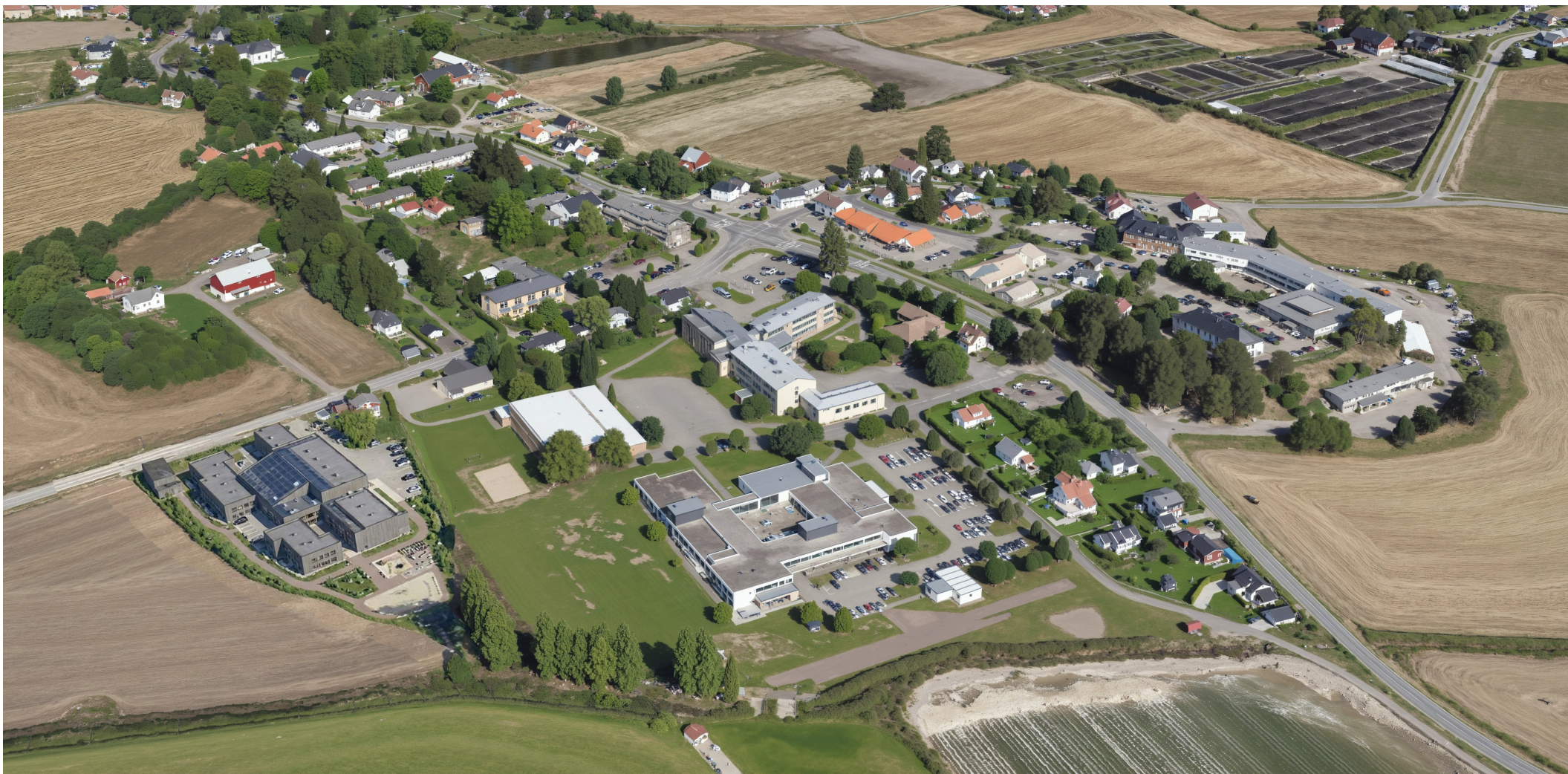
KI-generert oversiktsfoto av dagens situasjon. Unøyaktigheter kan forekomme og grunnlag ikke helt oppdatert til dagens situasjon
