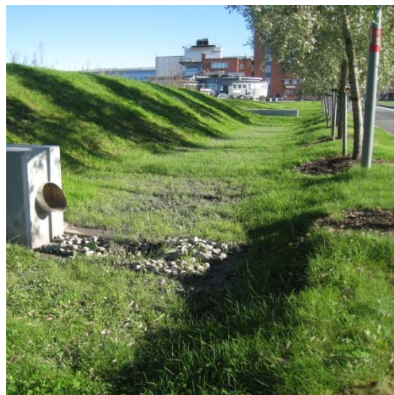
Langstrakt filterbasseng for gatevann plassert i et parkområde i by (Fornebu). Innløpet sees i forgrunnen. Anlegget har ikke forsedimenteringsenhet utover sandfang i gata (foto: COWI).
