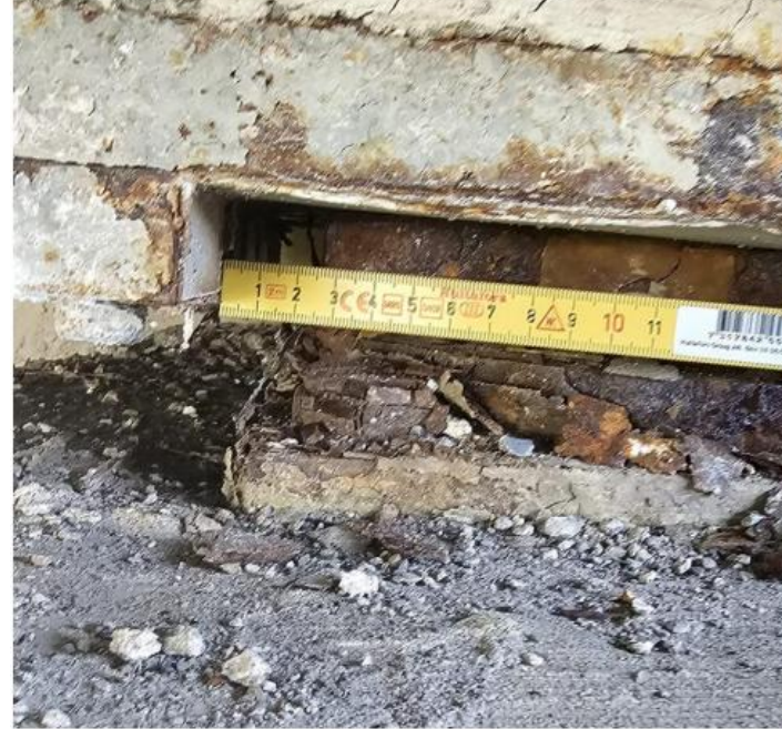
Figur 8 Vestre landkar. Nordre lager. Måling av sideveis forskvning.
