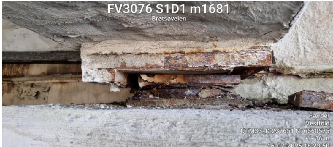
Figur 8 Vestre landkar. Nordre lager. Måling av sideveis forskvning.
