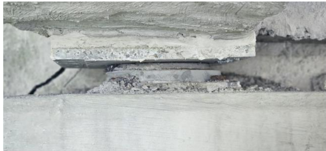
Figur 9 Vestre landkar. Søndre lager. Viser betydelig sideveis forskvning.
