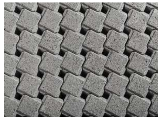
Permeabel belegningsstein. Fugene/hulrommene fylles med grovkornet materiale.
