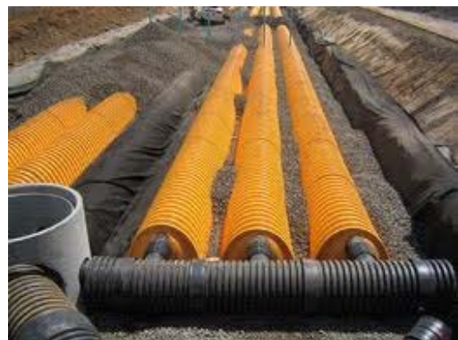
Eksempel på fordrøyning i halvt rørmagasin kombinert med infiltrasjon (foto: VA Systemer AS)
